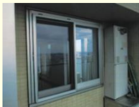
施工後(防音用サッシ)
