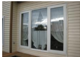
施工後(防音用サッシ)
