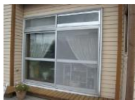
施工後(防音用サッシ)
