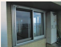
施工後(防音用サッシ)
